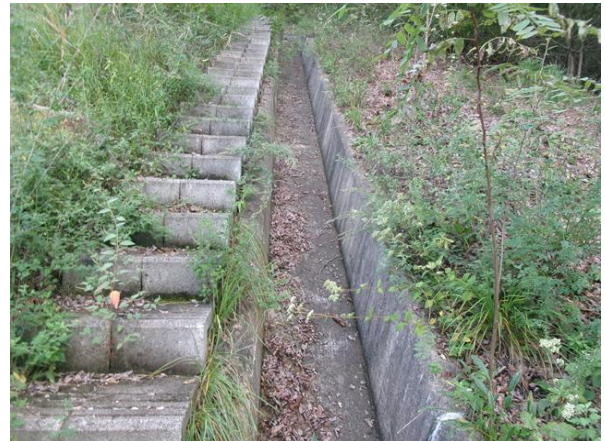
점검계단, 산마루측구 전경
