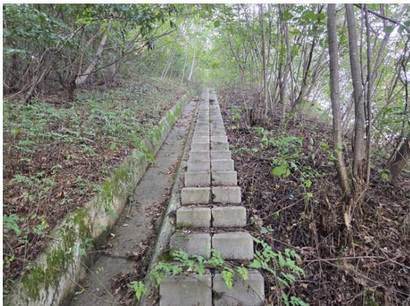
산마루측구, 점검계단 전경
