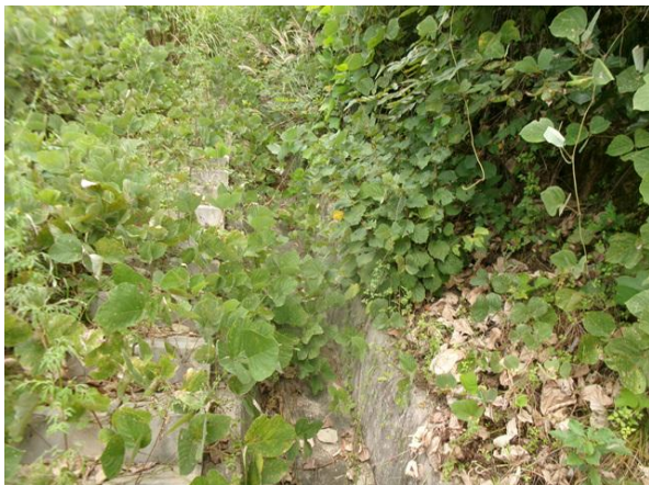
산마루측구, 점검계단 전경
