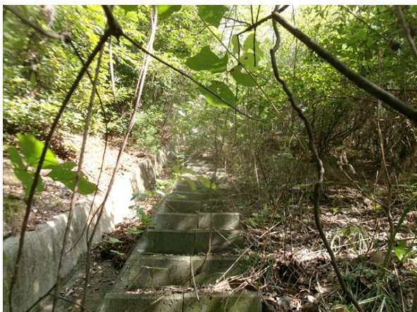
산마루측구, 점검계단 전경
