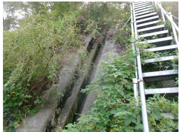
수직도수로, 점검사다리 전경
