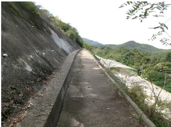
1소단 배수로 전경
