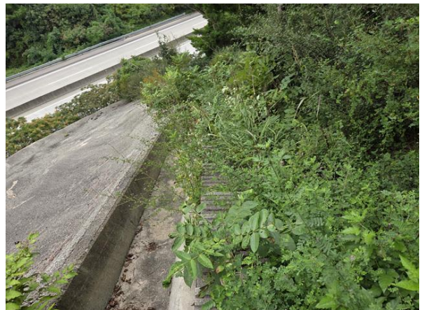
점검계단, 산마루측구 전경
