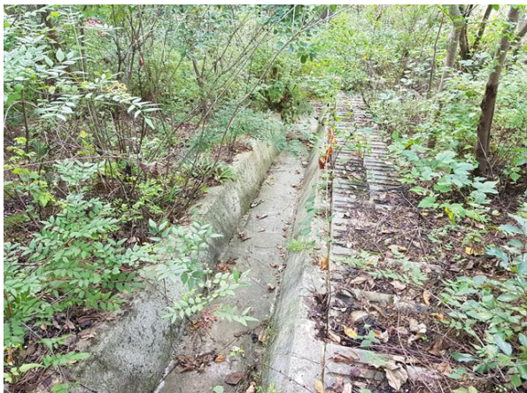
산마루측구, 점검계단 전경
