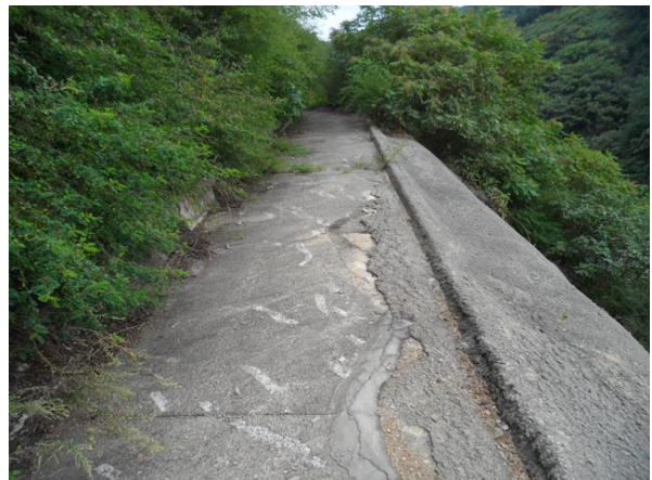
1소단 배수로 전경
