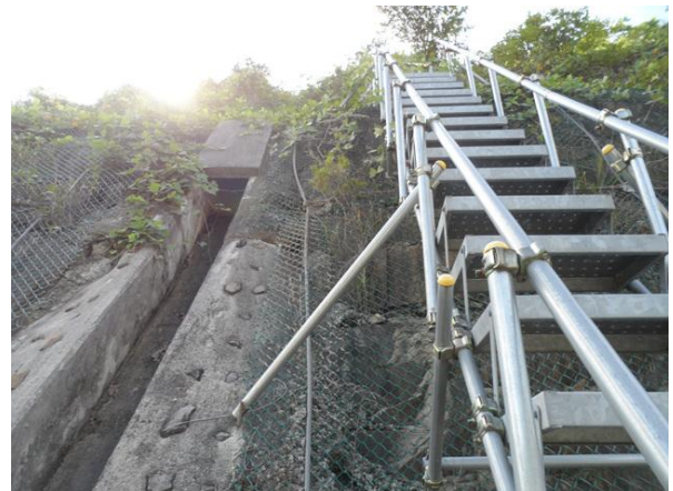
수직도수로, 점검계단 전경
